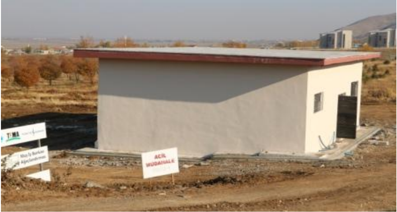
Resim 10 Trafo Yapım İşi
